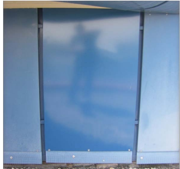
▲ Bild 23: Detailaufnahme Metallfassade blau pulverbeschichtet mit Reinigungsmusterfläche
