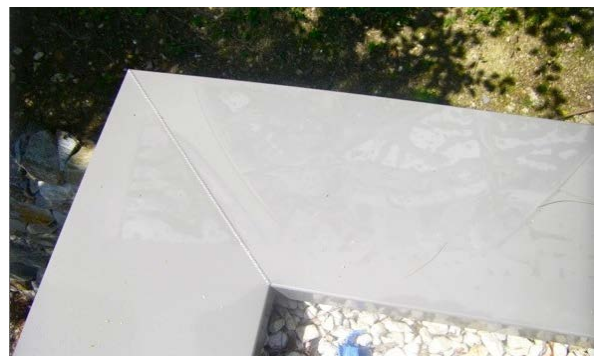
▲ Bild 15: Wasserflecken, Folie entfernt Fleckenbildung auf einem Aluteil durch längere Lagerung in Folie im Freien
