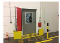
Abb. 2: Einrichtung zu Löschwasserrückhaltung
