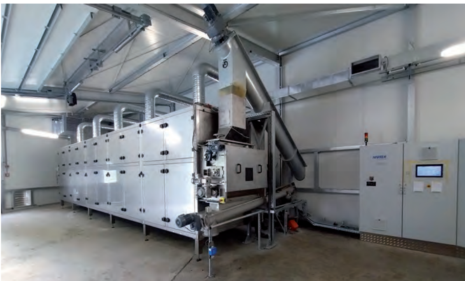
Die Klärschlamm-trocknungsanlage in Erpfendorf besteht aus fünf Wärmepumpenmodulen; diese stellen die erforderliche Prozessluft bereit und sind ebenso für den Kondensationsprozess verantwortlich
