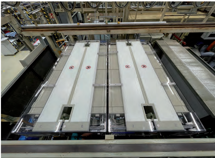
Abb. 2: Gestelle mit teils stark schöpfenden Bauteilen befinden sich im Wärmepumpentrockner. Deckelsysteme sorgen für den Erhalt der wertvollen Wärme im System
