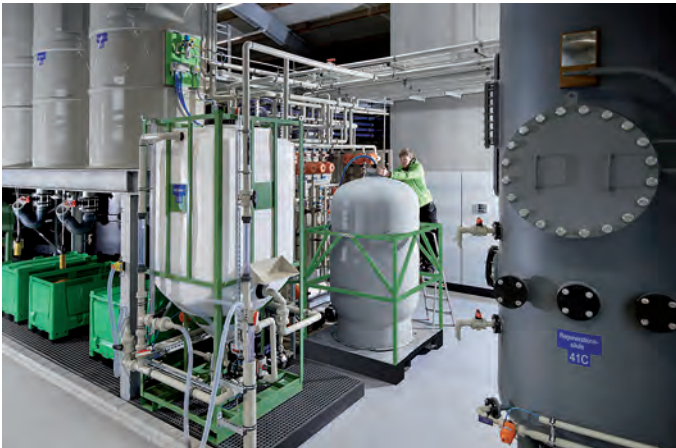
EnviroFALK Einzelplatz-Regeneration eines mobilen Selektivionenaustauschers in transportabler Gestellanlage (Bild: EnviroFALK)
