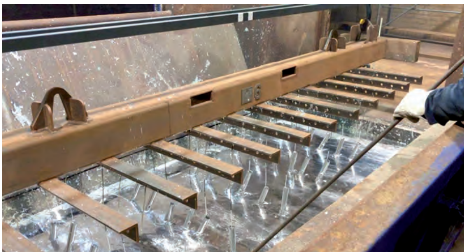
Bauteile werden durch Tauchen in geschmolzenes Zink in den Anlagen bei Pfingsten feuerverzinkt
