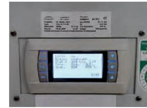
**Die kompakte Wärmepumpe (l.) benötigt inklusive Wärmetauscher eine Fläche von etwa zwei Europaletten. Die Verifizierung der eingesparten Heizleistung erfolgt durch einen Energiemengenzähler (r.), die Kontrolle von Temperatur und Durchfluss mittels Display** (Bild: Ecoclean)
