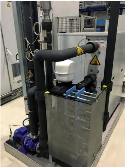
**Der Anschluss der Wärmepumpe an die bestehenden Wasserkreisläufe erfolgte durch vier neue Rohrleitungen. Zwei verbinden den Saubewassertank auf der Anlage mit dem Wärmetauscher. Die anderen transportieren das warme Wasser aus dem Kühlkreislauf zur Wärmepumpe und abgekühlt wieder zurück** (Bild: Ecoclean)
