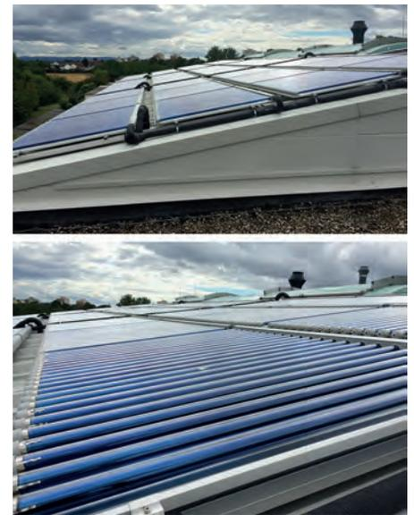
**Abb. 3: Solaranlage mit 300 m<sup>2</sup> CPC-Kollektoren bei Heinz Daurer & Söhne GmbH & Co. KG (Bild: Universität Kassel)**
