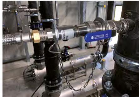
**Dosierlanze in einer Abwasseranlage, die im Betrieb ohne Leckage installiert, gewechselt oder entfernt werden kann (Bild: Chemfeed)**
