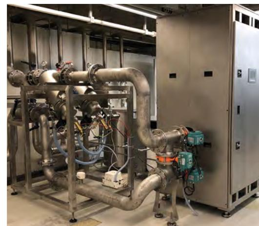
**Die kompakten Anlagen für die Aufbereitung und Desinfektion von Brauch-, Prozess- und Trinkwasser stehen mit einem Durchsatz von zwei bis 250 Kubikmeter pro Stunde zur Verfügung**
