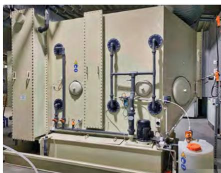
**EVO Scrubber mit 50 000 m<sup>3</sup>/h und 550 kW WRG-Leistung in liegender Bauweise**
