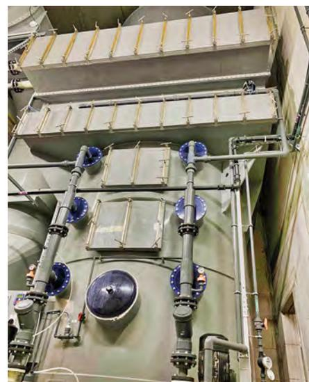
**EVO Scrubber mit 70 000 m<sup>3</sup>/h und 725 kW WRG-Leistung in stehender Bauweise**
