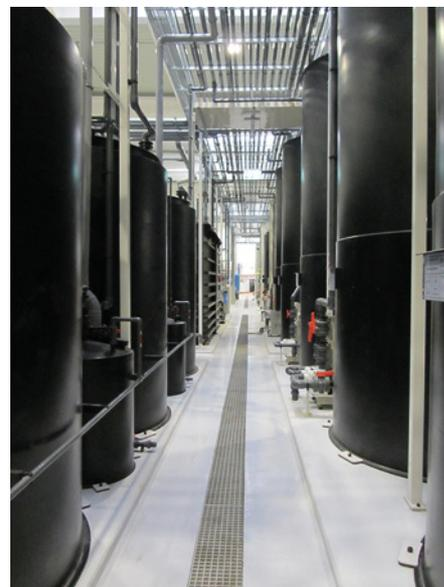
**Blick in die Reihe mit den großdimensionierten Behältern für das Wassermanagement der neuen Galvanikanlage bei Hansgrohe**
