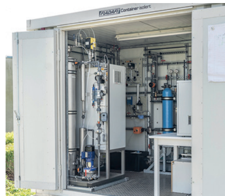
Transportable Anlage zur Abwasserbehandlung mit integriertem Analysegerät für Spurenschadstoffe
