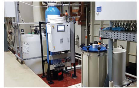
Abb. 7: Dosierung und Ionentauscher für den Chrom(III)prozess
