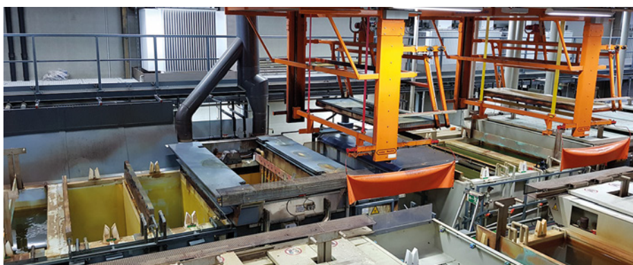
Abb. 1: Inhouse-Anlage bei der Sedus Stoll AG in Dogern
