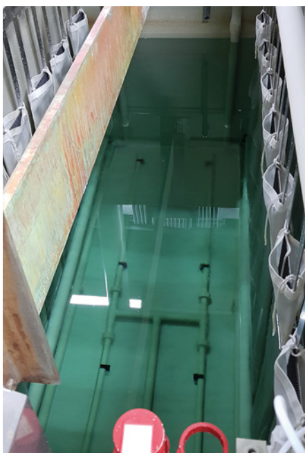
Abb. 5: Befüllen des neuen Behälters für den Chrom(III)elektrolyten
