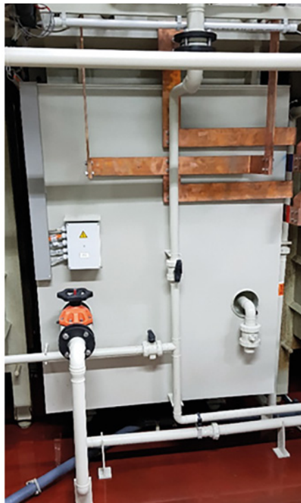
Abb. 3: Ausstattung des Behälters mit Mischoxidanoden (links) und neue Verrohrung der Anlage
