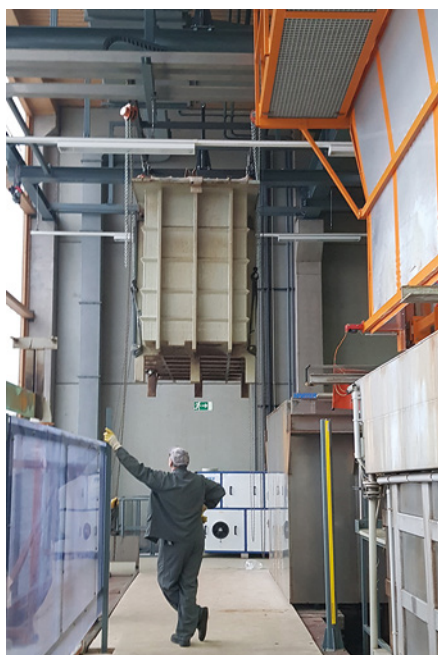
Abb. 6: Einbringen der neuen Chromwanne
