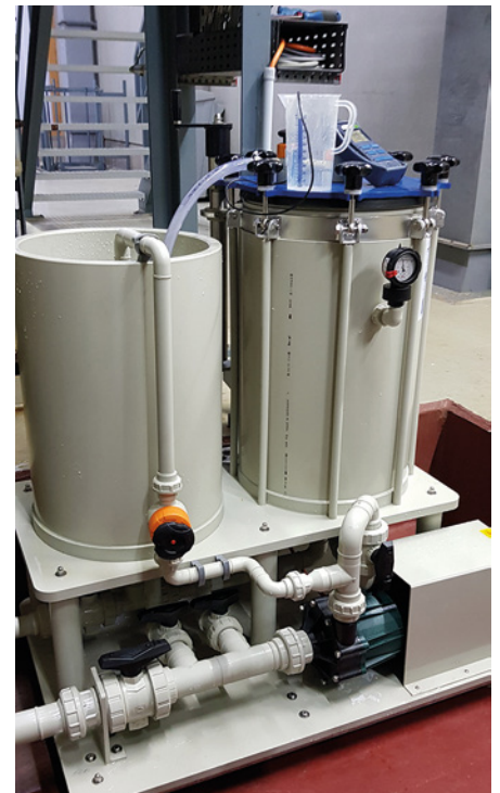
Abb. 4: Filtration für den Chrom(III)elektrolyten
