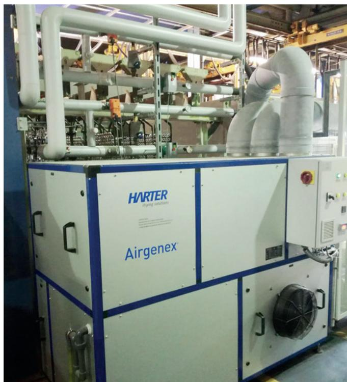
Das Airgenex-Entfeuchtungsaggregat stellt die erforderliche Prozessluft zur Verfügung
