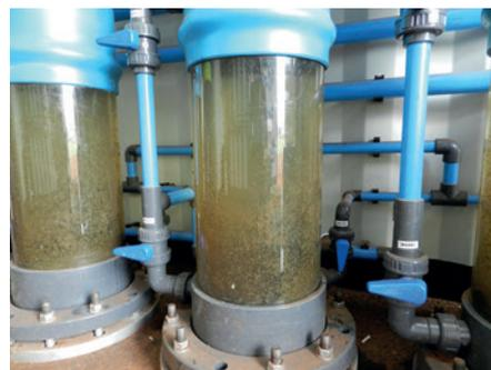
Koagulations- und Flockungssäulen zur Klärung des Flusswassers
