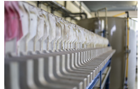
Kammerfilterpresse für die Abwasserbehandlung von Selektivionenaustauschern
