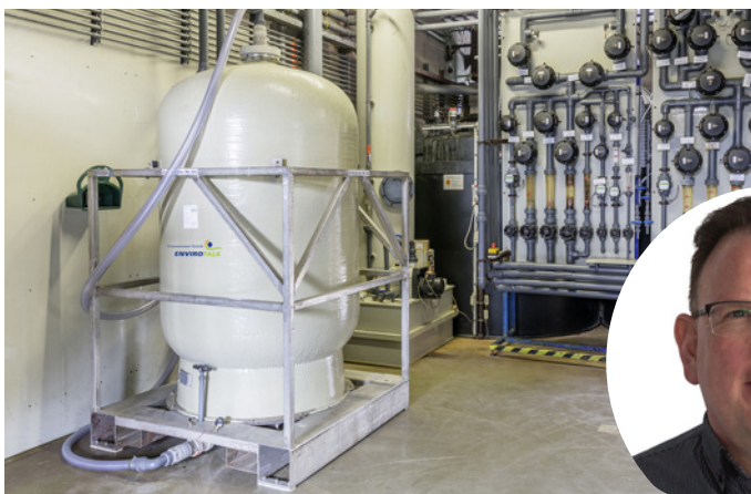
Regeneration eines mobilen Selektivionenaustauschers als transportable Gestellanlage
