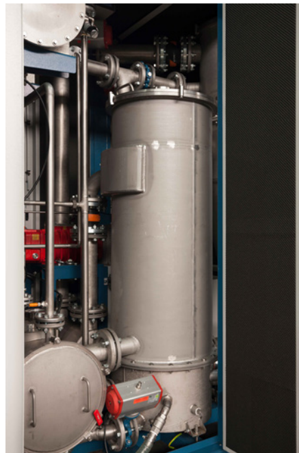
Wärmetauscher der neuen Anlage
