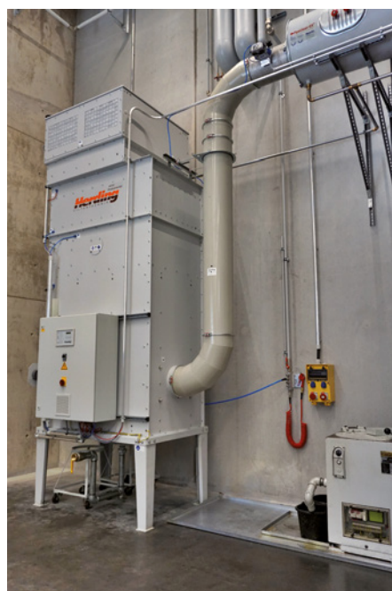
Kompaktes Kühlschmierstoff-Absaugsystem mit drei integrierten Filterstufen für die Rückführung der gereinigten Luft in die Halle und Rückgewinnung von abgeschiedenem Kühlschmiermittel
