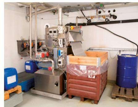
**Separate Schmutzstoffe werden über den separat untergebrachten Bandfilter ausge-tragen**
