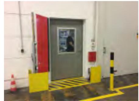
Abb. 2: Einrichtung zu Löschwasserrückhaltung
