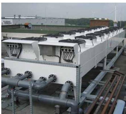
Mit einem Freikühler, der bei kälteren Temperaturen die Kälte bereitstellt, lässt sich der Energiebedarf einer Kälteanlage signifikant senken.
