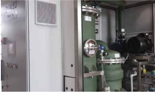
Verdampfer zur Reduzierung der Abwassermenge
