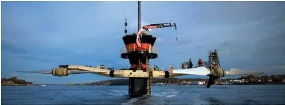
Abb. 1: Horizontalachsenturbine SeaGen zur Nutzung von Meeresströmungsenergie [6]
