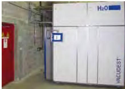
Die Vacudest 250 Clearcat wird für die Entfettungsspülwässer aus der Fahrzeugreinigung eingesetzt
