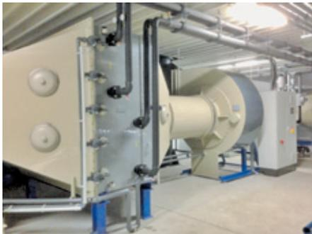
Abb. 1: Wärmerückgewinnungsanlage mit 240 kW Wärmeleistung bei 50 000 m<sup>3</sup>/h Abluftvolumen
