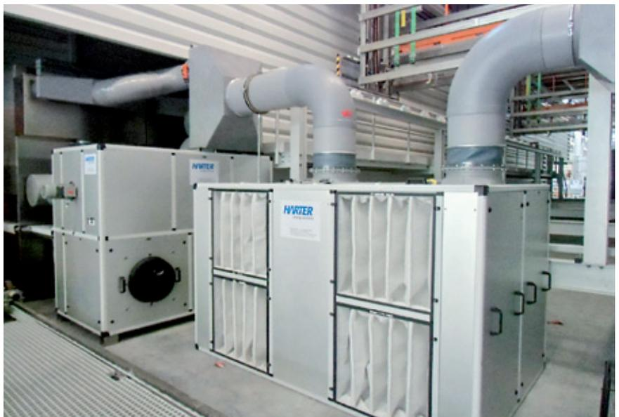
Airgenex®-Trockner und Mitteldruckventilatoren
