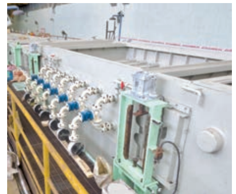
Ein Spritzmodul am Einlauf einer Beizlinie während der Montage, im Hintergrund sind die Tauchbecken zu erkennen
