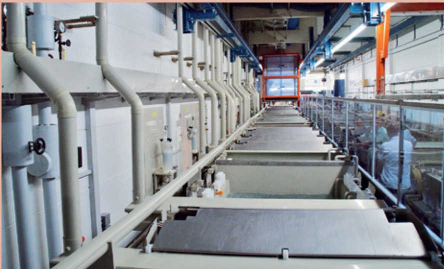
Die neue DNC-AL-Anlage im Gesamtüberblick
