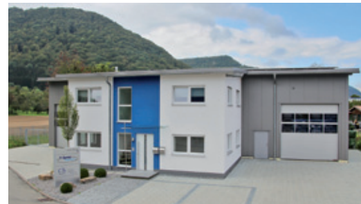
Das neue Firmengebäude der T-Spray GmbH Foto: T-Spray
