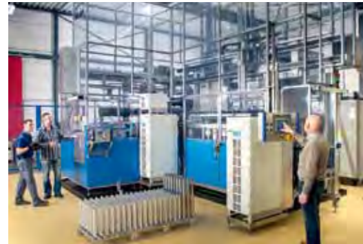
Vollautomatische Selga-Coat® Chrom-Anlage zur Serienbeschichtung bei AHC Benelux in Venlo
