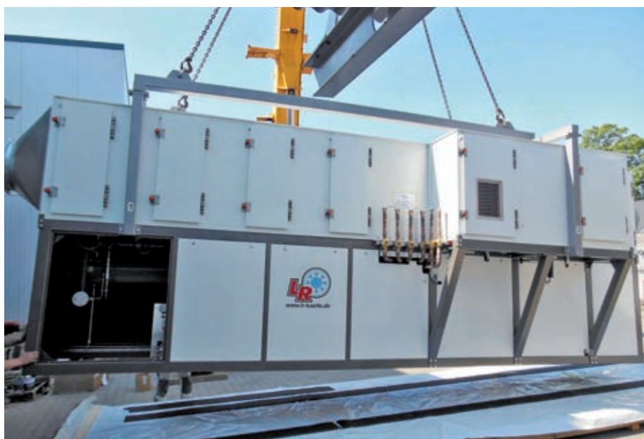
Im L&R-Werk Sundern wurde die Anlage weitestgehend vormontiert und seegerecht verpackt, so dass die Inbetriebnahme vor Ort durch L&R-Personal mit möglichst geringem Aufwand verbunden war
