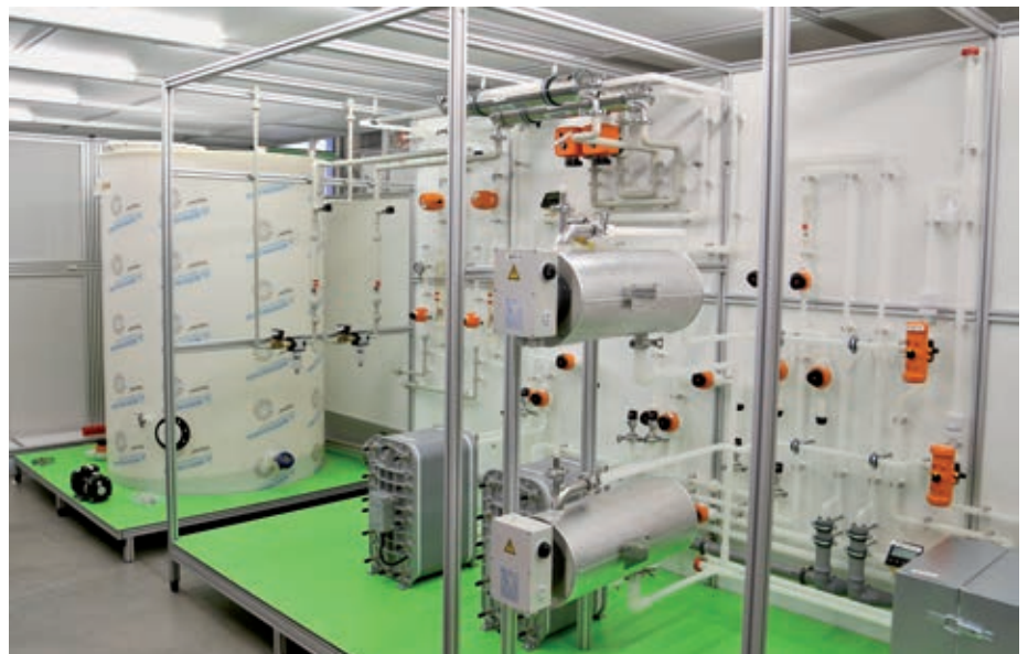
Um während des Herstellungsprozesses der Wasseraufbereitungsanlage keine Partikel in die Anlage einzubringen, wird je nach Anwendungsbereich die komplette Fertigung in einem mobilen Sauberraum unter partikelarmen Bedingungen durchgeführt
