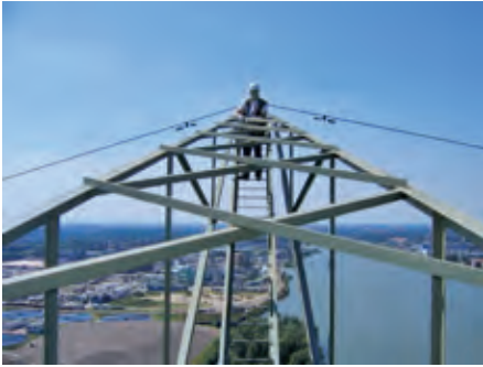
Beschichtungsprüfung auf einem Kran 29
