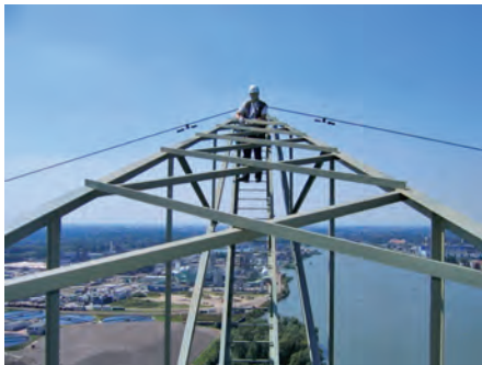
Beschichtungsprüfung auf einem Kran
